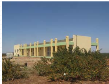
Face ouest de la communauté
